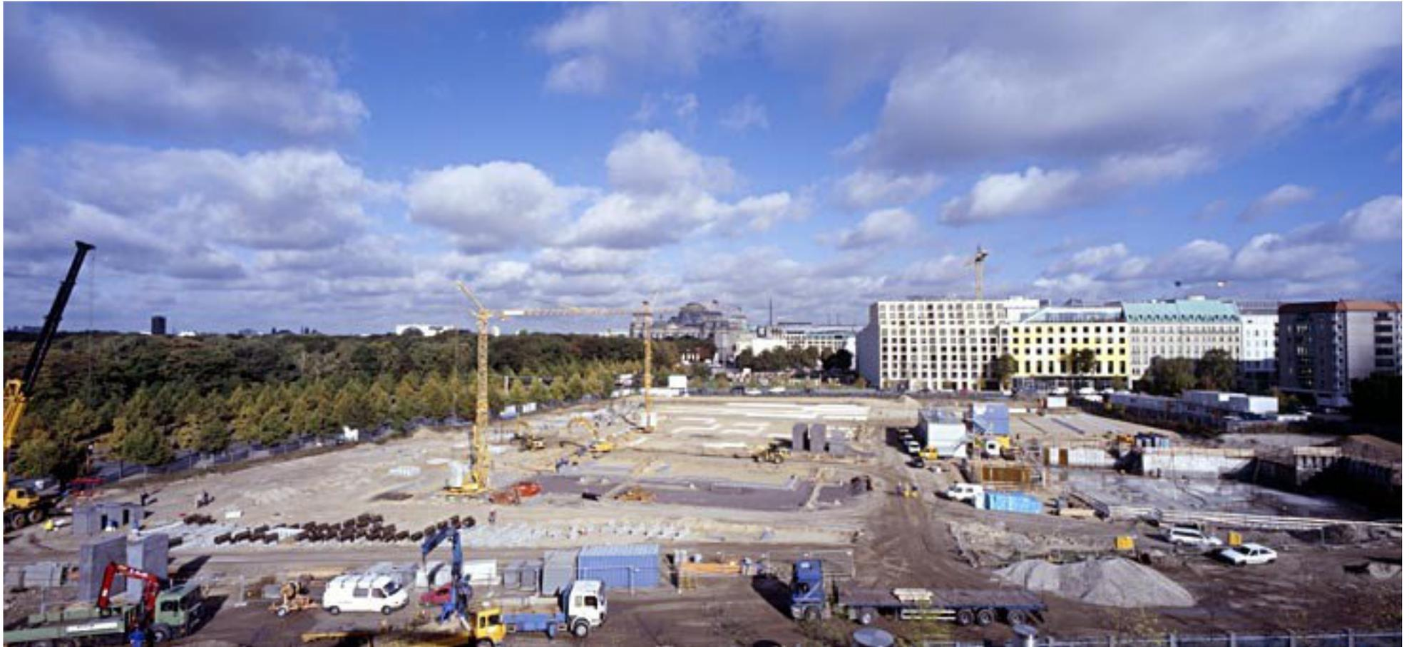
Die Stelenaufstellung beginnt ganz links. Nun sind vorn links die Feinfundamentformen aus Stahl, die für die genaue Kippung der Stelen eingemessen werden, montiert.
