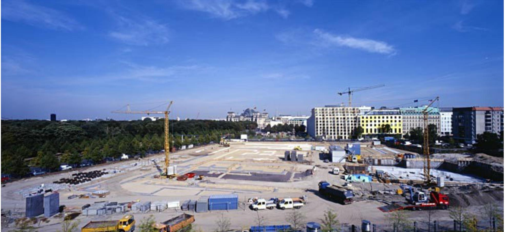
Die Fundamente im Kiesbett sind links fertig, darauf werden die Stahlformen für die genauen Fundamente der Stelen gesetzt. Der Kellerraum für das Infozentrum befindet sich bereits rechts im Bau.
