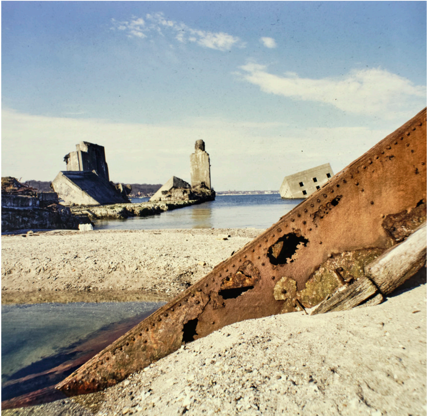
Bunker Kilian - gesprengt (heute Hafenfläche)
