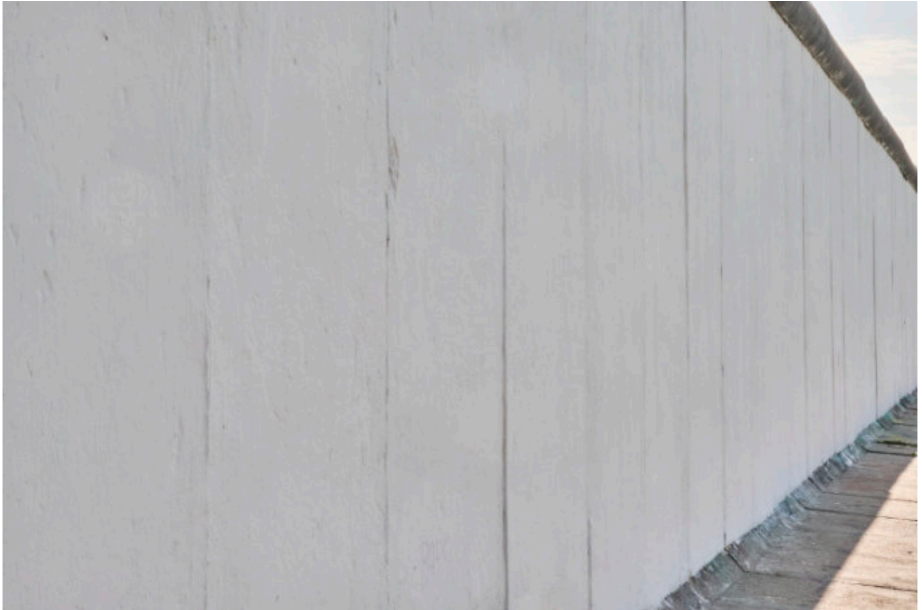
Berliner Mauer zur Spree - weiß gestrichen zur Entdeckung auch des kleinsten flüchtigen Schattens.
